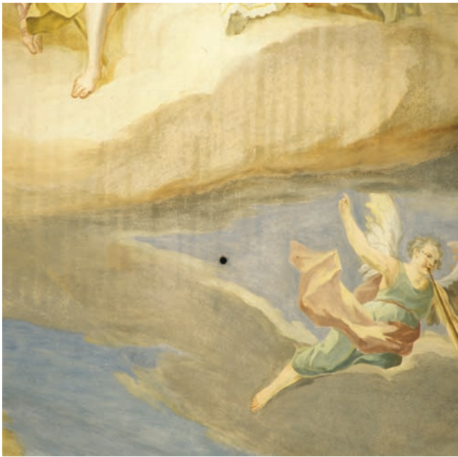
Abb. 3. Wies (Gem. Steingaden, Kr. Weilheim-Schongau), kath. Wallfahrtskirche zum Gegeißelten Heiland, Deckenbild im Kirchenschiff, Ausschnitt: streifiges Muster, der Lattung des Putzträgers folgend (2007).
