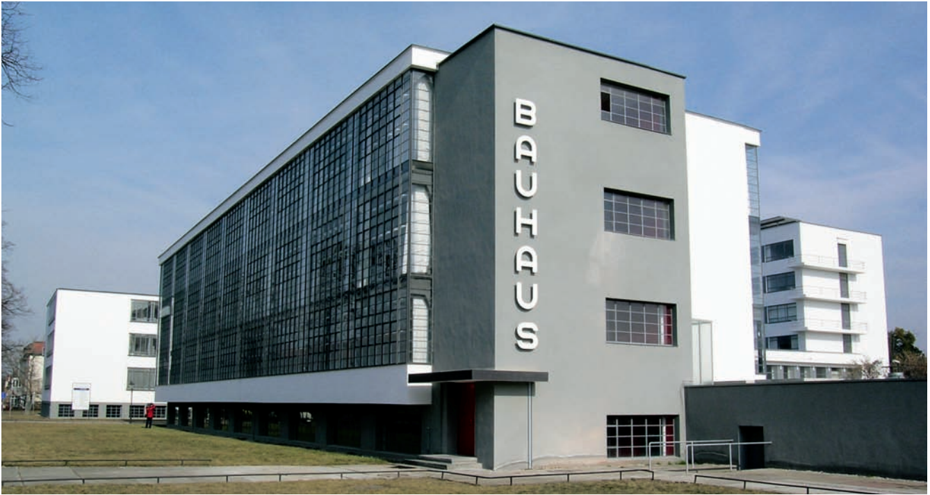
Abb. 1. Dessau, Bauhausgebäude nach Abschluss der Restaurierung 2006.
