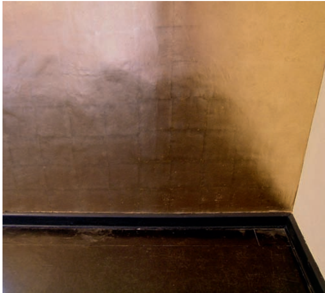
Abb. 5. Dessau, Meisterhaushälfte Kandinsky: sogenannte Goldnische nach der materialidentischen Rekonstruktion (2004) auf dem durch eine Pufferschicht geschützten Original; neuerliche mechanische Schädigungen nach weniger als zwei Jahren touristischer Nutzung.
