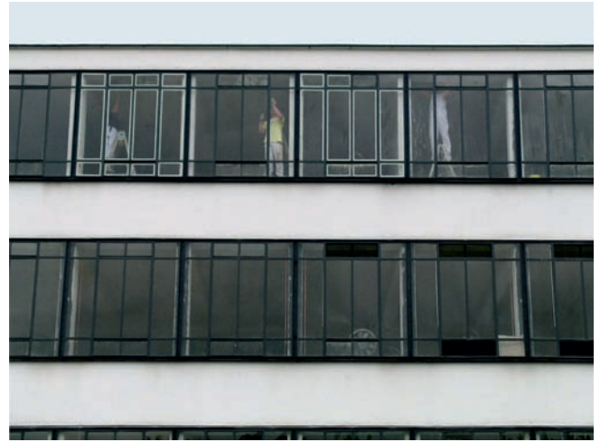
Abb. 11. Dessau, Bauhausgebäude: Fachschultrakt während der „Pinselrenovierung“ der Fenster.
