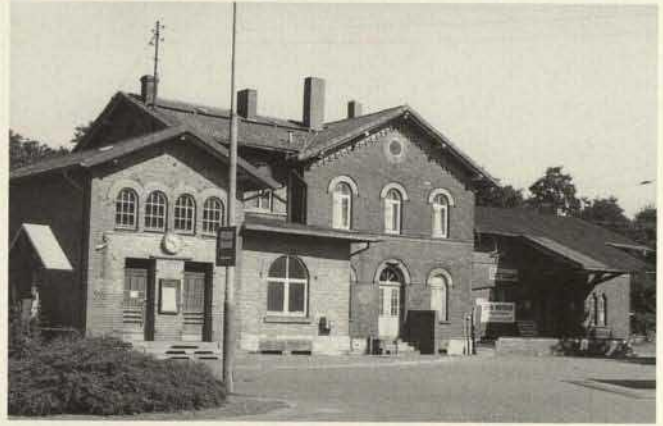
Abb. 37. Algermissen, Bahnhof, Hauptgebäude (Stadtseite), errichtet 1847 (Zustand 1982).
