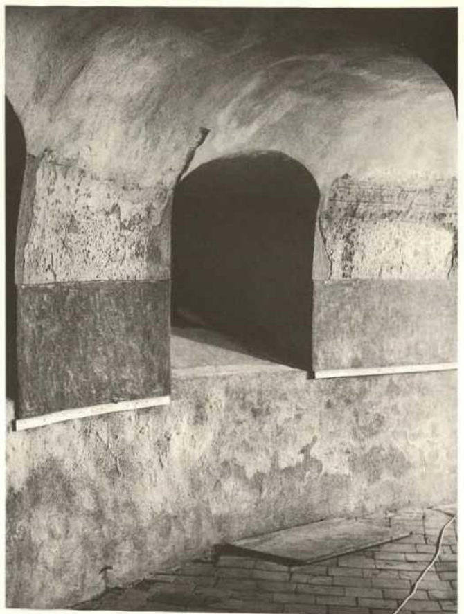
Abb. 142. Regensburg, St. Emmeram, Ringkrypta, nördlicher Ringgang, Außenwand (Zustand 1995).
