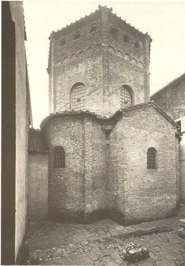
Abb. 207. Novara, Baptisterium. Außenansicht von Nordosten (Zustand um 1967).
