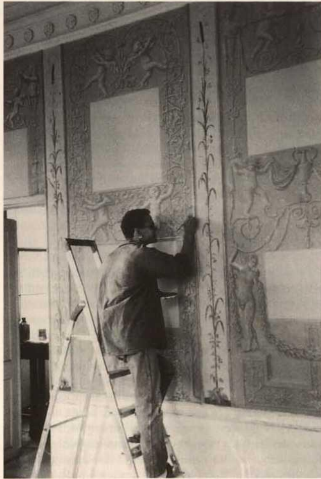
Restaurierungsarbeiten im Rhein-Schütz-Zimmer
