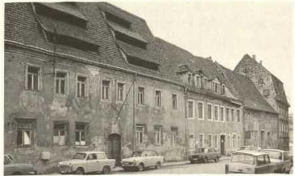
11 Pirna, Häuserzeile in der Langen Straße, die im Rahmen des Modellvorhabens interdisziplinär untersucht wird.
