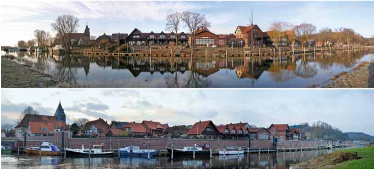
Abb. 3: Hitzacker (Elbe), oben: Stadtansicht im Vorzustand, unten: Nach Errichtung der Hochwasserschutz-Wand – above: view of the town before flood protection measures, below: after erection of the flood protection wall
