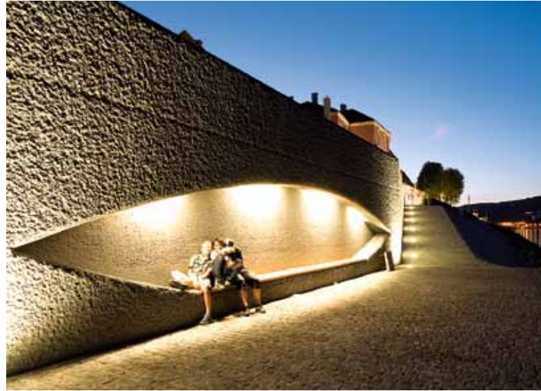
Abb. 5: Ybbs an der Donau, Donauplatzform nach Fertigstellung des Hochwasserschutzes, 2011
