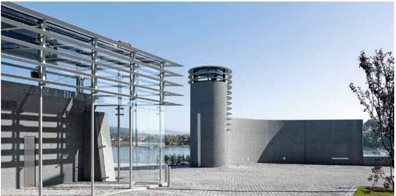
Abb. 4: Ybbs an der Donau, Promenade nach Fertigstellung des Hochwasserschutzes mit Pegelturm, 2011
