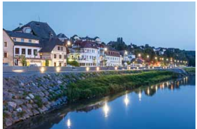
Abb. 8: Melk, Lände als Teil des Hochwasserschutzes, 2015
