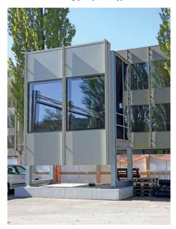
Abb. 7: Das Fassadenmuster, im Hintergrund die originale Fassade
