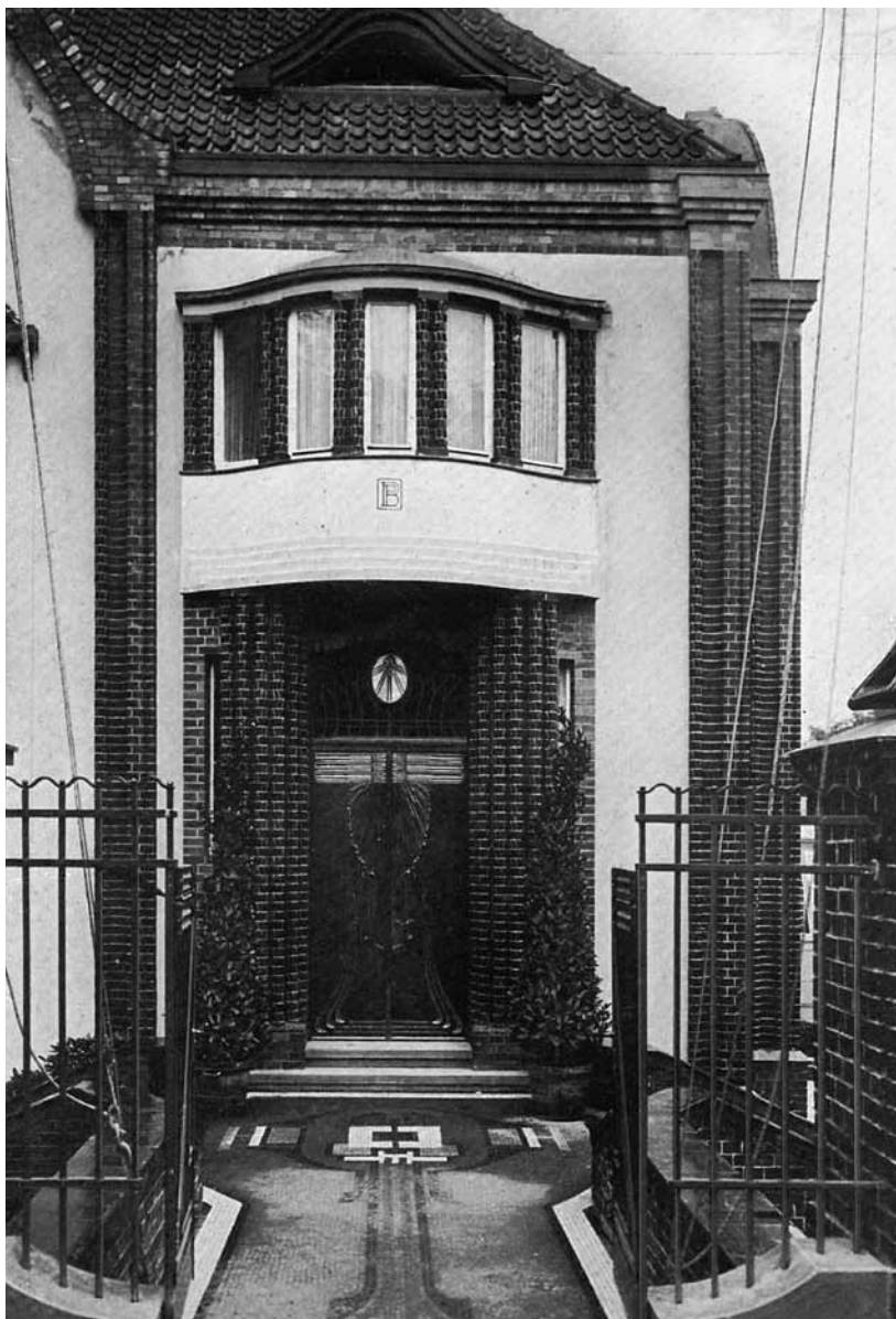
13 Peter Behrens, Haus Behrens, Haupteingang, Darmstadt, 1899–1901
