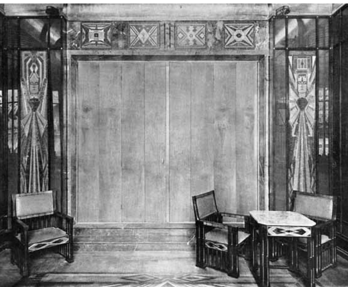
6 Peter Behrens, Haus Behrens, Schiebetüren Musiksalon-Esszimmer, Darmstadt, 1899–1901
