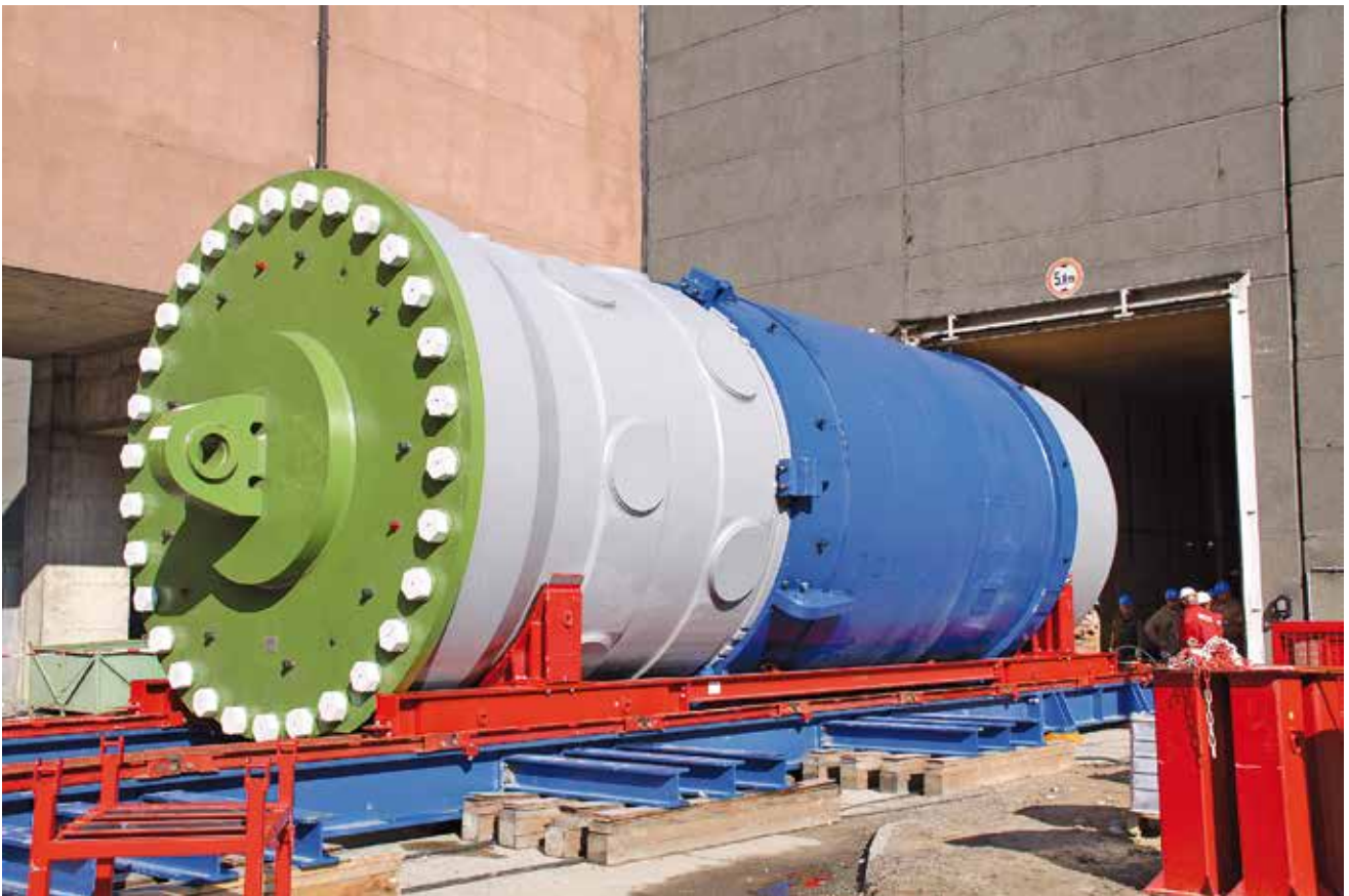
Abb. 6: Transport eines abgeschirmten RDB aus dem Reaktorgebäude zum ZLN.
