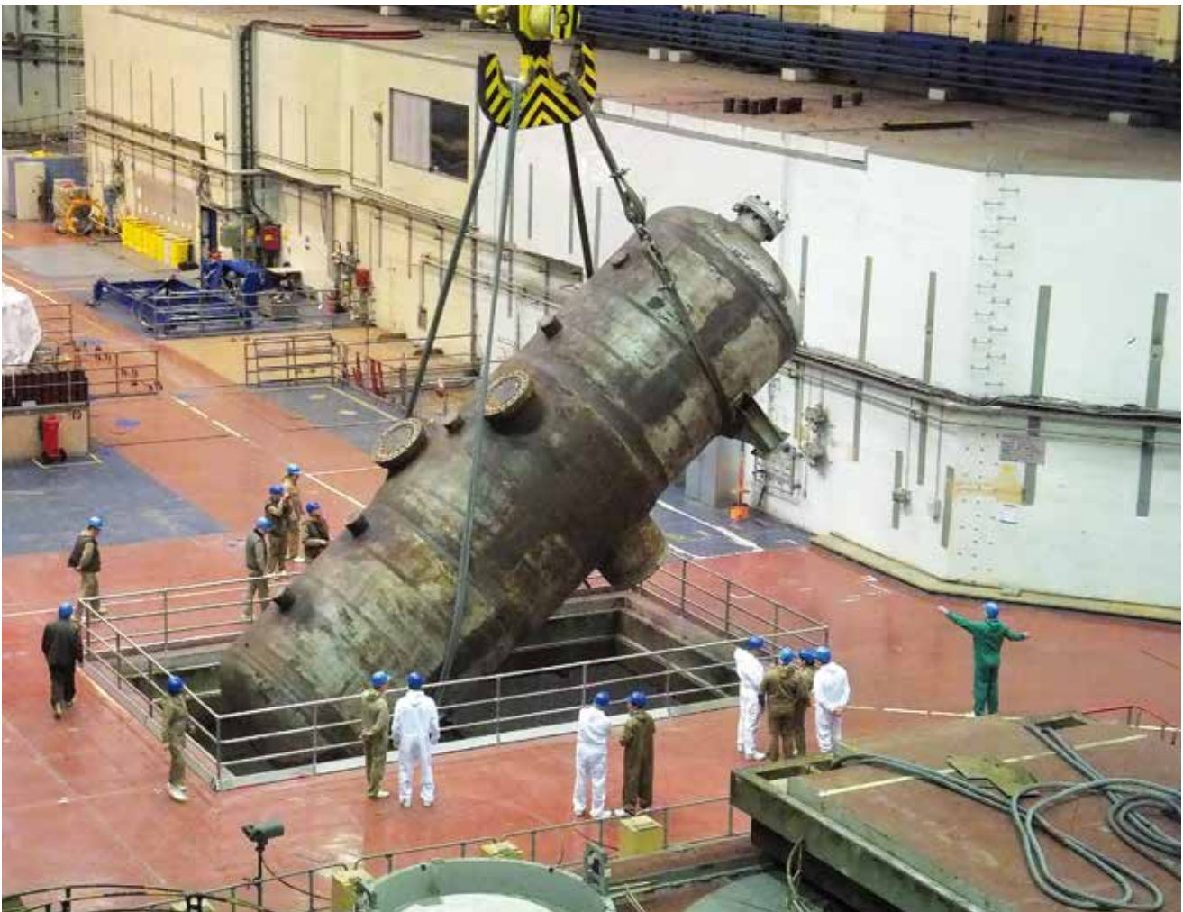
Abb. 4: Demontage eines Dampferzeugers im KGR.
