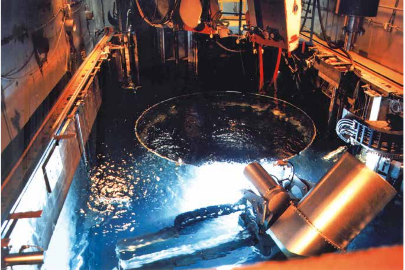
Abb. 5: Nasszerlegeplatz während der Modelldemontage im KGR.
