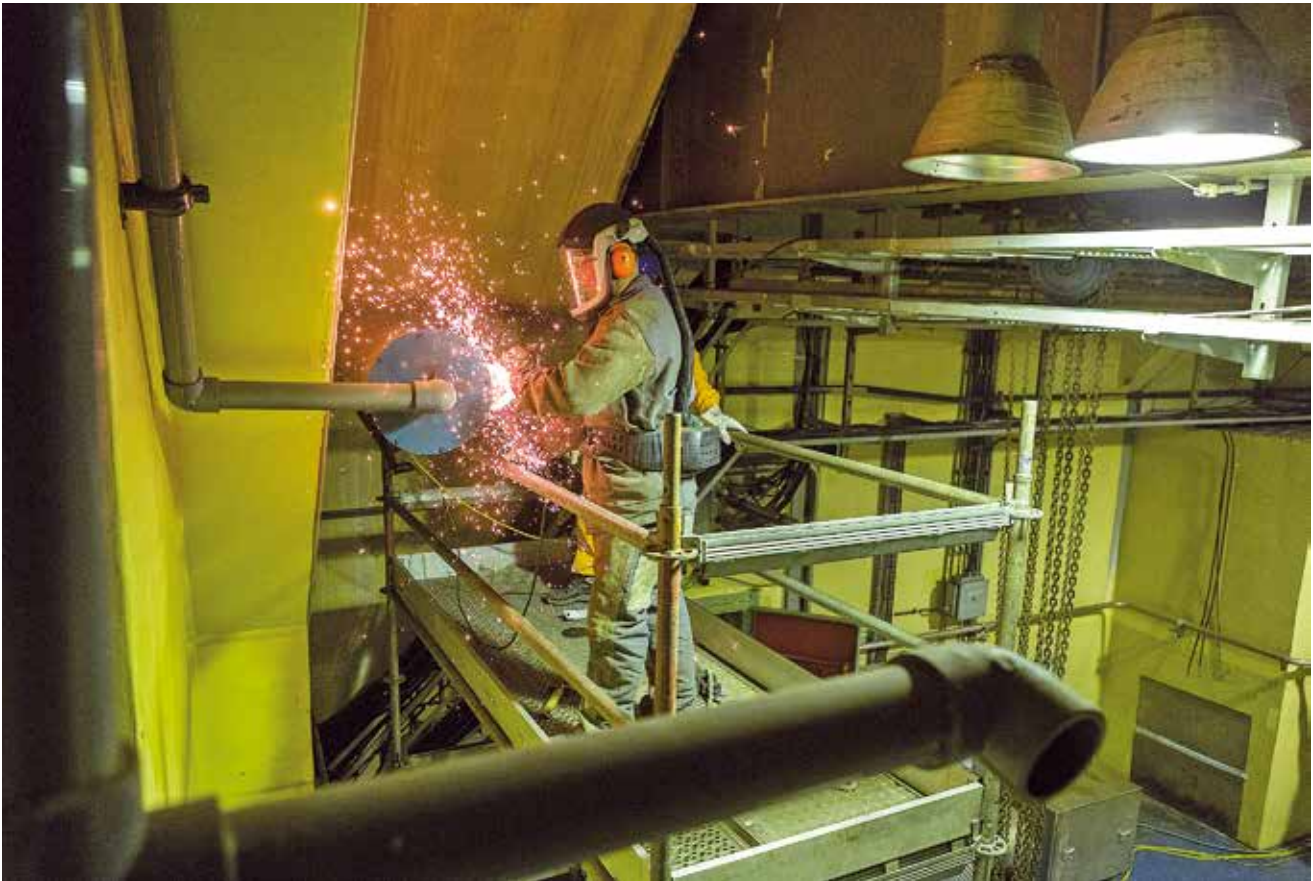
Abb. 7: Trennung von Rohrleitungen im KGR.
