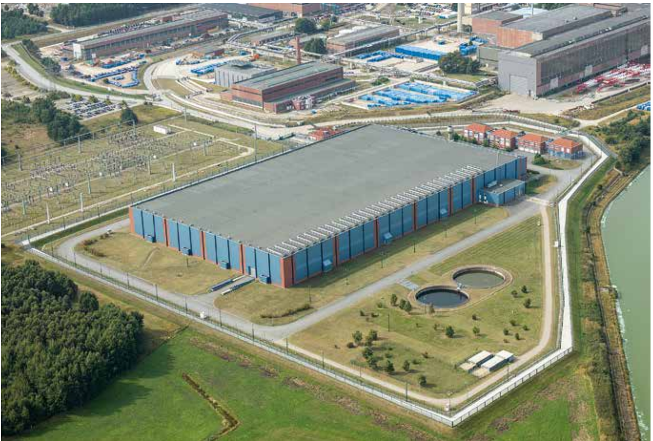
Abb. 3: Blick auf das Zwischenlager Nord (ZLN).
