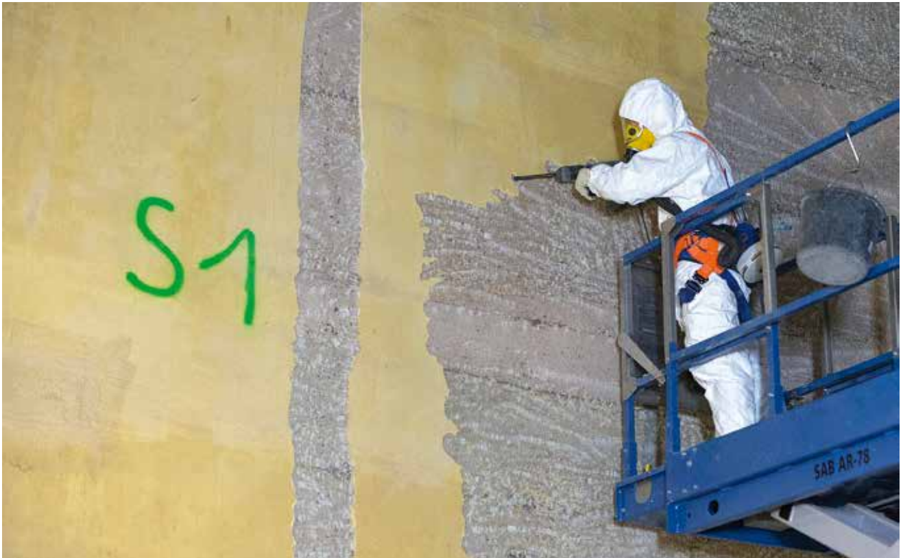
Abb. 8: Entfernung von losem Spachtelmaterial von der Betonwand (KGR).
