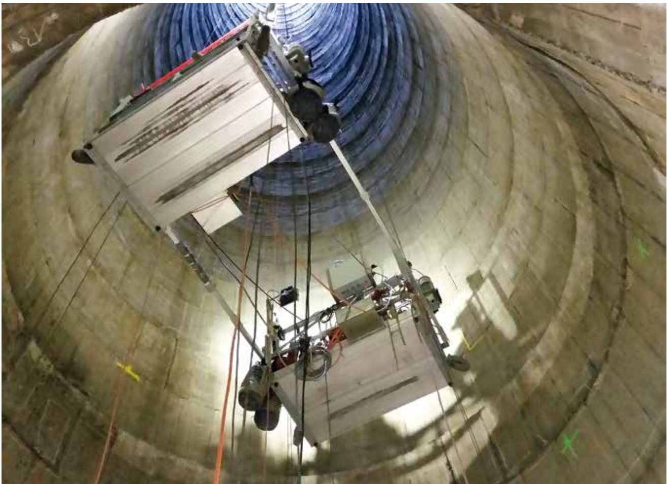
Abb. 9: Arbeitsbühne für Dekontamination und Freimessung im Kamin Nord I (KGR).
