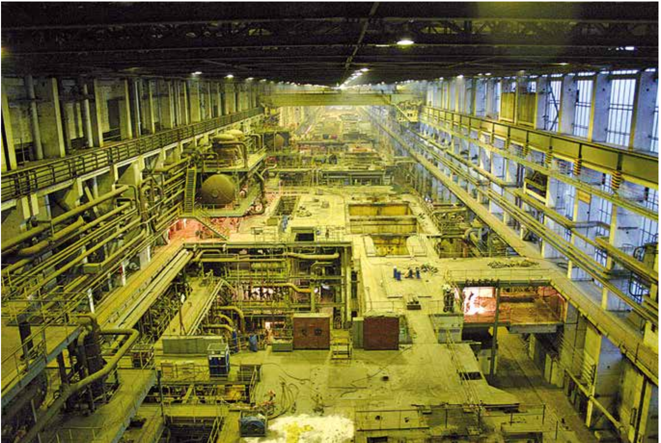
Abb. 2: Maschinenhaus während der Demontage (KGR).
