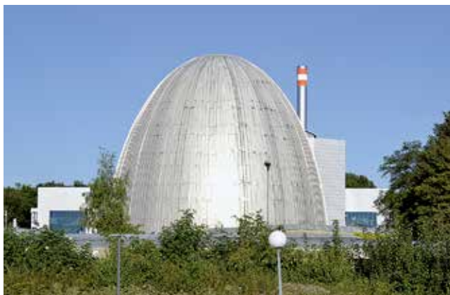
Abb. 7: Der Forschungsreaktor München I (FRM I) auf dem Gelände der Technischen Universität München.
