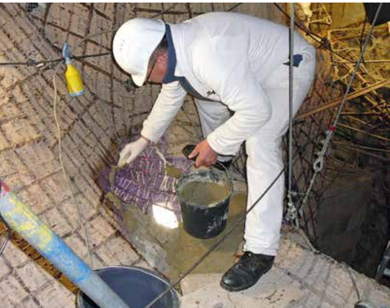
Abb. 4: Anlegen eines Reparaturmusters
