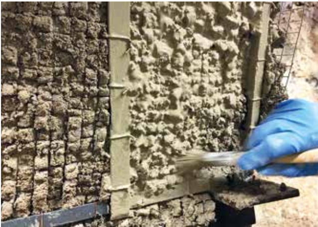
Abb. 19: Auftrag der Romanzementschlämme auf den erhärteten Rückseitenmörtel
