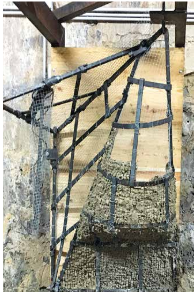
Abb. 18: Muster im Zwischenzustand mit Teilapplikation Rückseitenmörtel
