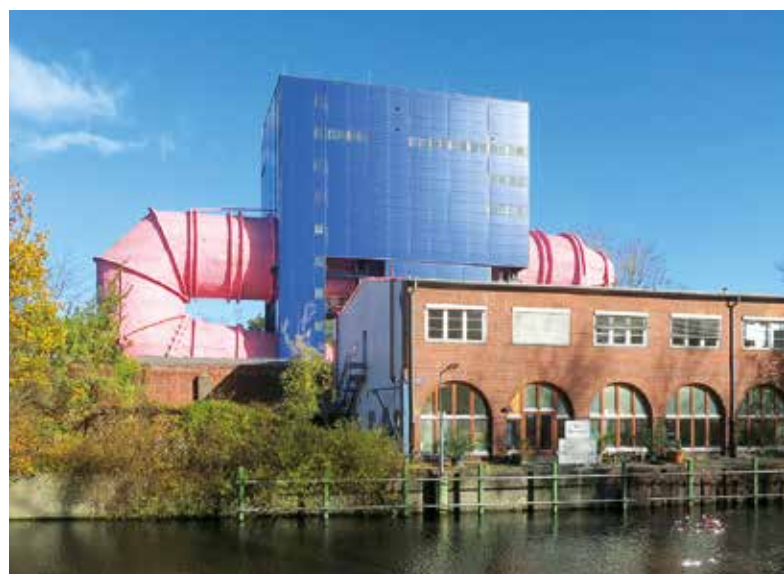
Fig. 2: South elevation after restoration, 2017 (© adb Ewerien und Obermann)
