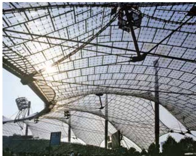
Abb. 2 Dach des Olympiastadions in München 1972, Foto: Christian Kandzia
