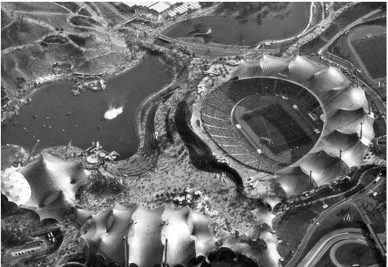
Abb. 1 Luftbild südlicher Bereich des Olympiaparks mit Hauptsportstätten und See während der Spiele 1972, Foto: Max Prugger
