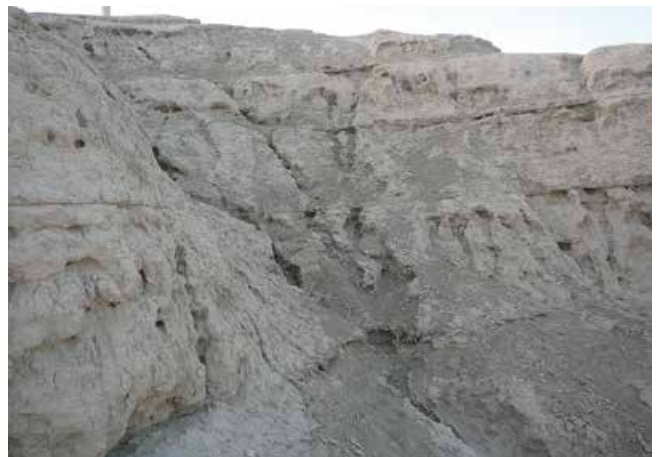
Abb. 7: Uruk. Kern der Eanna-Zikkurat. Regentäler graben sich in den Kern ein und verursachen zunehmende Zerstörung (Foto: Margarete van Ess)
