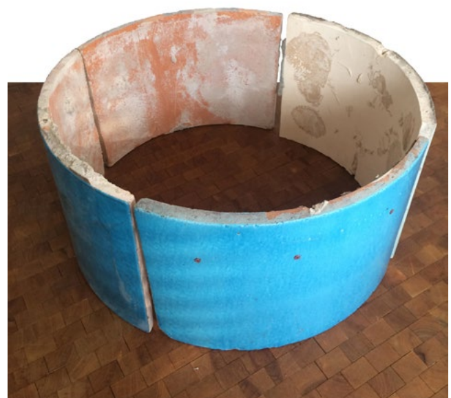
Abb. 8: Geborgene Teile der Keramikverkleidung der Stützen des U-Bahnhofs Sendlinger Tor (eröffnet 1971), München. Foto, Januar 2019
