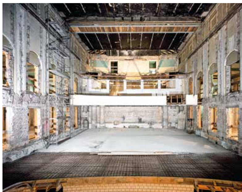
Abb. 4 Der Zuschauerraum nach Rückbau der Wandverkleidungen aus den 1970er Jahren, Aufnahme 2006
