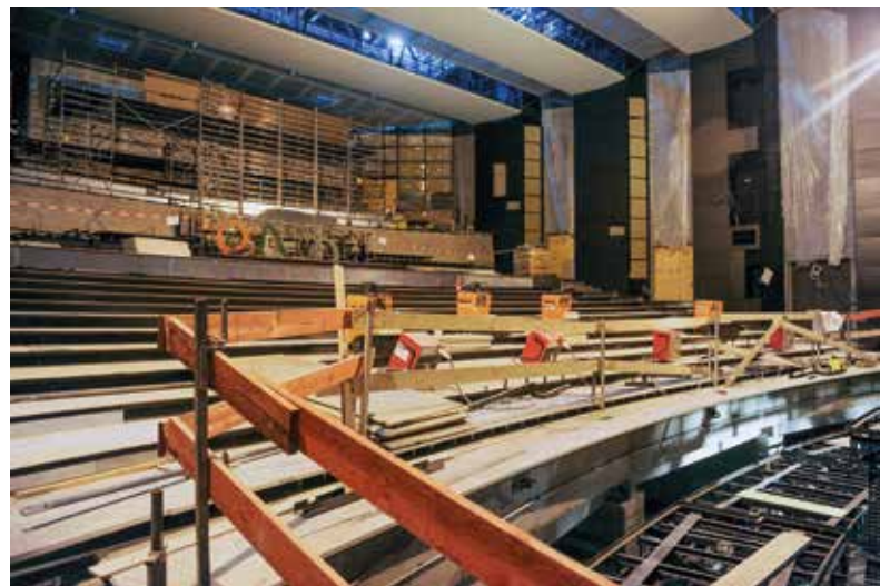
Abb. 6 Innenraum des Schauspielhauses während der laufenden Sanierung
