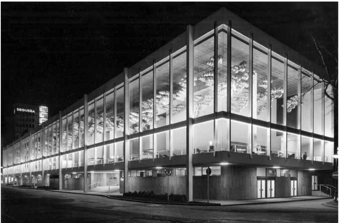
Abb. 1 Nächtlicher Blick von Nordwesten auf das Foyer; Aufnahme 1963, Foto: Jupp Faust
