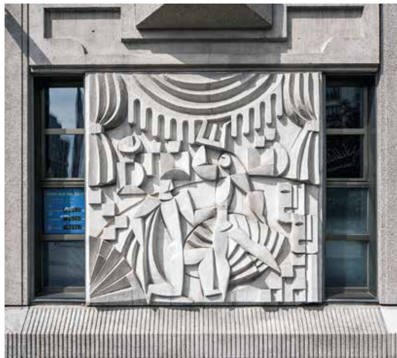
Abb. 3 Die „Platte“ aus Sichtbeton in Werksteinqualität mit dekorativen plastischen Elementen und einem Relief, Fassadendetail
