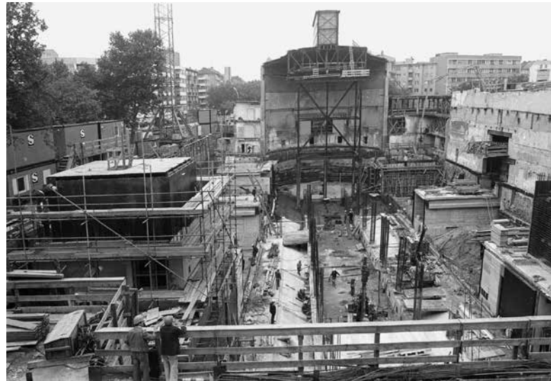
Abb. 5 Schaubühne am Lehniner Platz, Baustelle Mendelsohnbau, 20. Juli 1979, Fotograf: Jürgen Henschel
