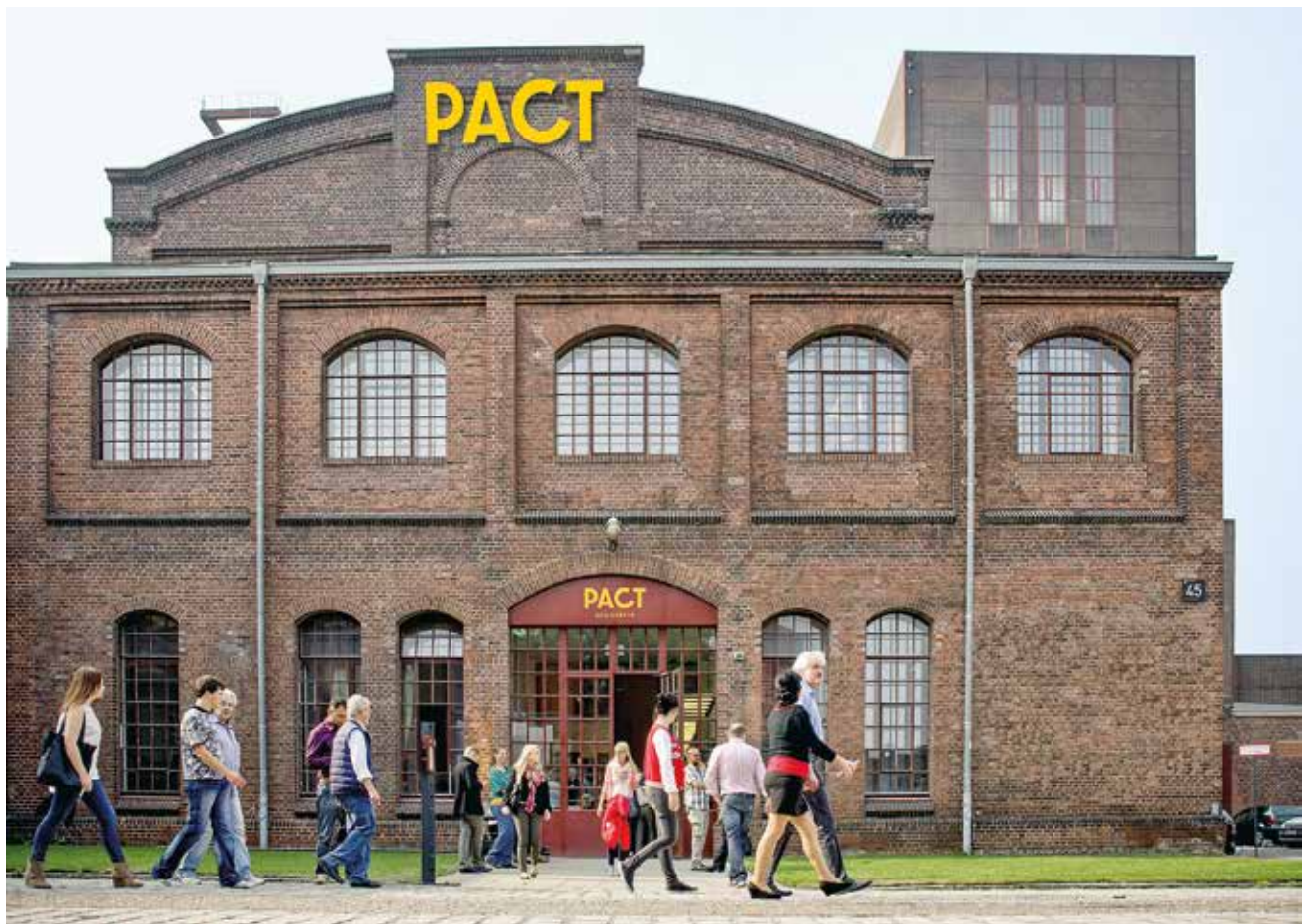
Abb. 8 PACT Zollverein Essen in der ehemaligen Waschkau Zollverein nach Instandsetzung (2000) von Christoph Mäckler; Fotograf: Dirk Rose
