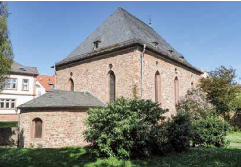
Abb. 18 Synagoge Worms von der Gartenseite mit dem Hauptbau der Männersynagoge und dem westlich angebauten Lehrhaus Raschi-Jeschiwa (Foto ICOMOS Deutschland, J. Haspel)
