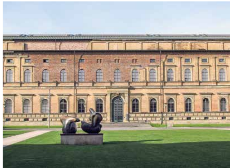
Abb. 4 Alte Pinakothek München (Leo von Klenze, 1833–1836): nach Kriegszerstörungen wiederaufgebaut nach Plänen von Hans Döllgast bis 1957; Schließung der Bombenlücke bei Wiederaufnahme der Gliederungsstruktur und des Öffnungssystem des Altbaus und Ausführung als unverputztes Ziegelmauerwerk (Foto Gras-Ober, 2012)
