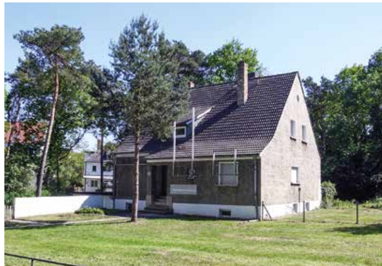
Abb. 14 Welterbestätte Bauhausstätten, Dessau Meisterhaussiedlung, Haus Emmer: nach der Kriegszerstörung des Direktorenhauses von Walter Gropius von 1956 bis 2011 an dessen Stelle, dann seinerseits durch eine abstrahierende Nachbildung des untergegangenen Gropius-Bauwerks ersetzt, um die städtebauliche Vorkriegswirkung im Siedlungsbild annähernd wiederzugewinnen (Foto M_H.DE)
