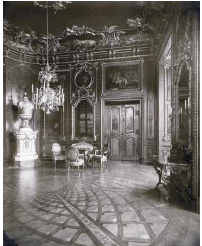
Abb. 6a Residenz Würzburg, Grünlackiertes Zimmer vor der Zerstörung, frühes 20. Jh. (Foto Bayerische Schlösserverwaltung)
