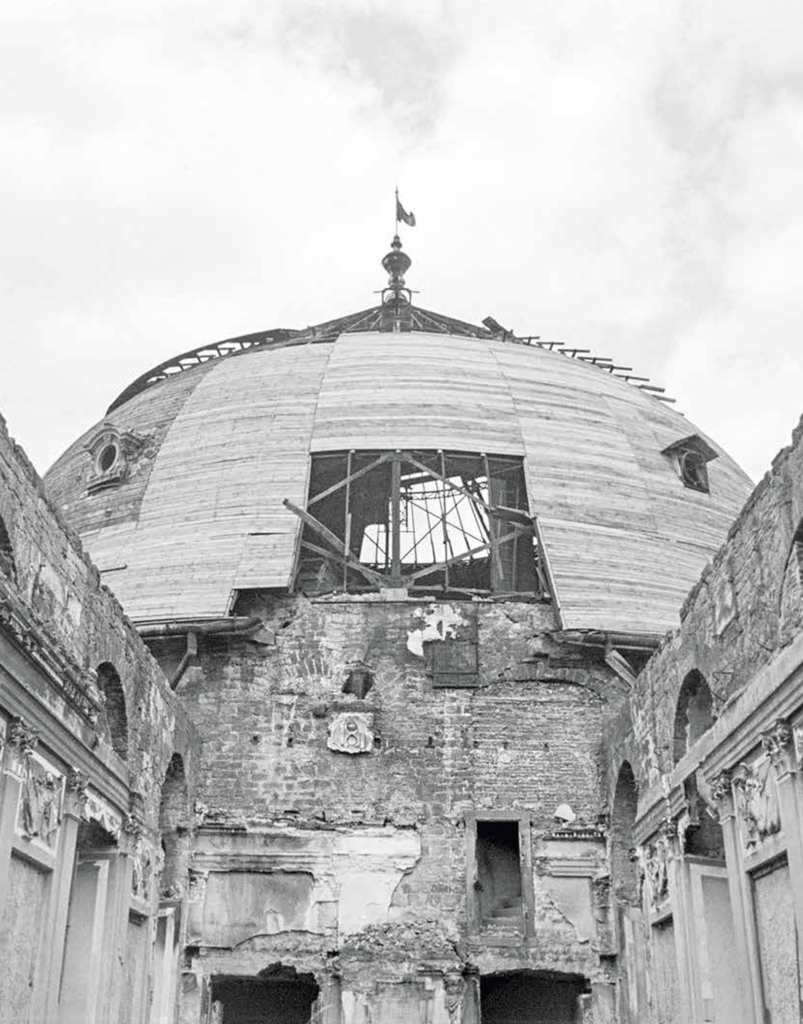
Abb. 2c Residenz Würzburg, Beginn des Wiederaufbaus nach den Kriegszerstörungen; hier: neue Schalung über der Nordkuppel, vom zerstörten Fürstensaal aus gesehen, um 1945–47 (Foto Bayerische Schlösserverwaltung)
