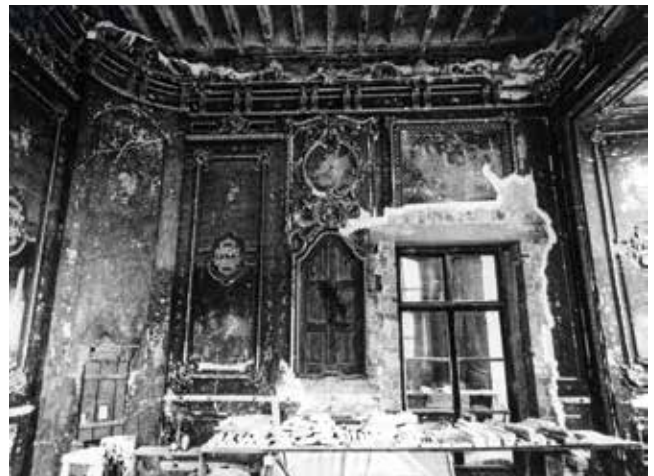
Abb. 6b Residenz Würzburg, Grünlackiertes Zimmer zu Beginn des Wiederaufbaus, Zustand 1945–46 (Foto Bayerische Schlösserverwaltung)
