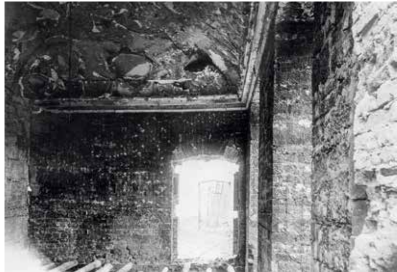
Abb. 3 Residenz Würzburg, Spiegelkabinett unmittelbar nach der Zerstörung von 1945 mit noch erhaltenen Fragmenten der Muldendecke und ihrer Stuckdekoration (Foto Bayerische Schlösserverwaltung, Schleinkofer)
