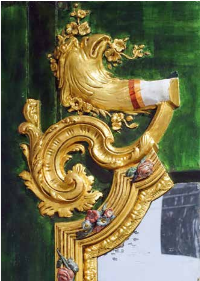
Abb. 3c Teilansicht der Musterplatte für die Wiederherstellung von Stuck, grüner Lüsterung und Vergoldung im Grünlackierten Zimmer, gefertigt in den frühen 1970er Jahren von den vor Ort tätigen Kunsthandwerkern, auf Grundlage der Untersuchungsergebnisse des Doerner-Instituts München vom 27. 07. 1970 (Foto Schloss- und Gartenverwaltung Würzburg, S. Vogt, 2022)
