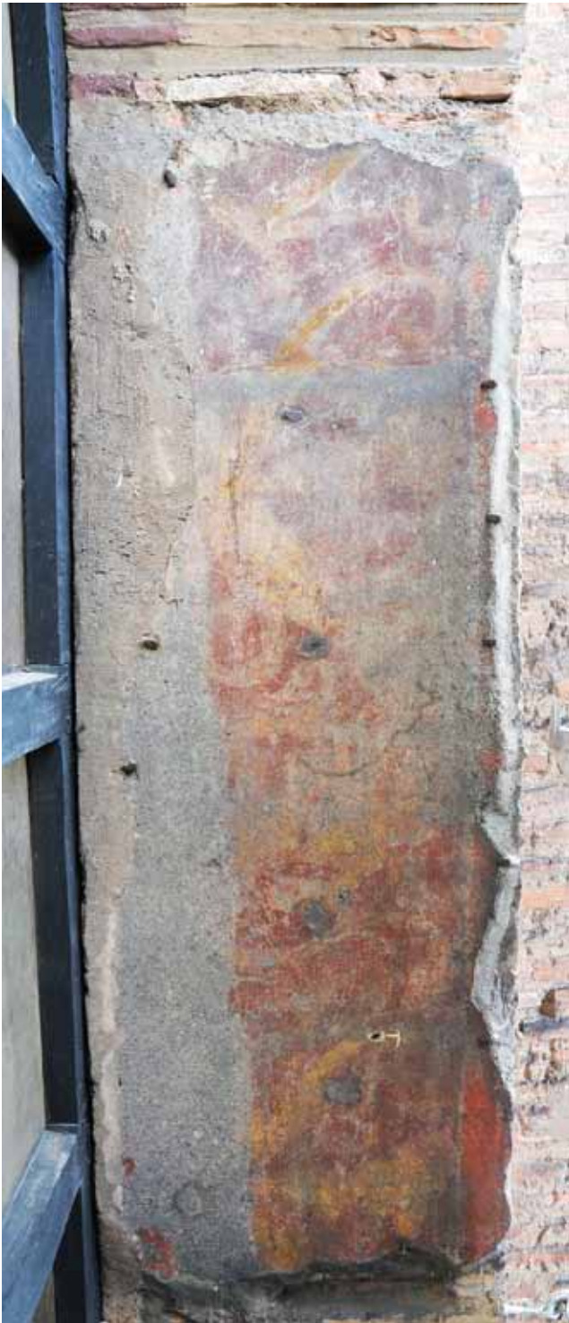
Abb. 1-6: Römische Wandmalerei an der Westfassade der Konstantinbasilika, südliche Fensterlaibung N11, Zustand 2009
