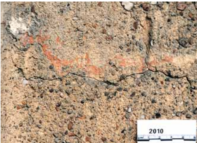
Abb. 4-13: Deutlich erkennbare Putzgrenze in der südlichen Fensterlaibung W08
