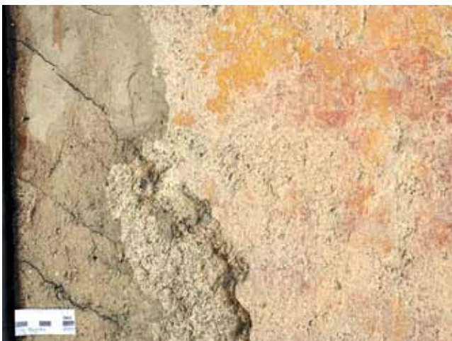
Abb. 4-35: Beispiel für die sorgfältige Mauerwerks- ergänzung des 19. Jahrhunderts
