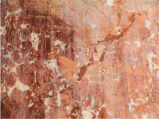
Abb. 6-9: Südliches Eingangportal des Doms zu Freising. Detail der südlichen Säule mit sekundärer Streifenbildung des mit dem Pinsel aufgetragenen Polyesters durch expositionsbedingte Korrosion des Polymerfilms (Maßnahme von 1972), 1998
