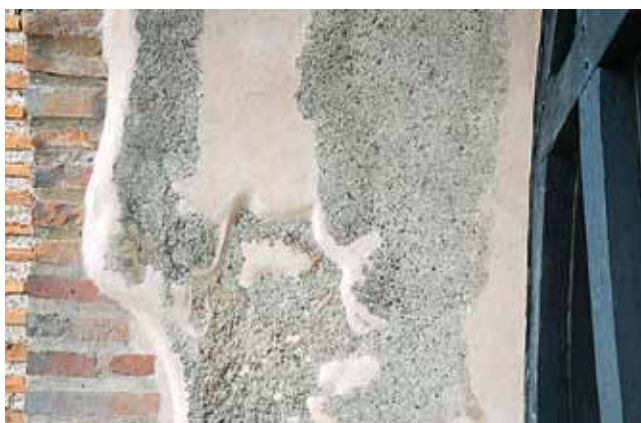
Abb. 7-19: Mechanische Entfernung von zementgebundenen Ergänzungsputzen
