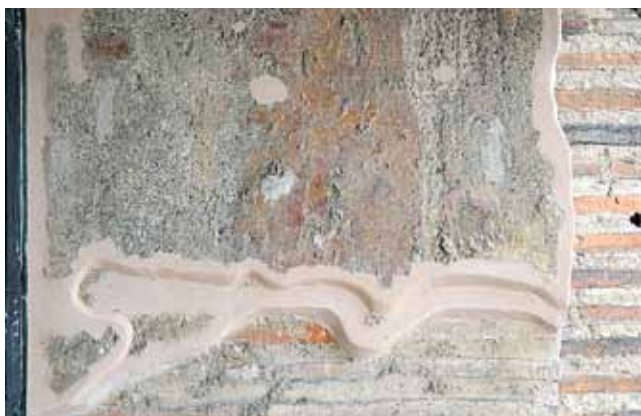
Abb. 7-20, 7-21: Randanböschungen und Ergänzungsputze am Beispiel von Fensterachse W9
