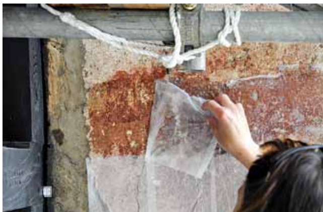
Abb. 7-16: Festigung der Malschicht über Japanpapier
