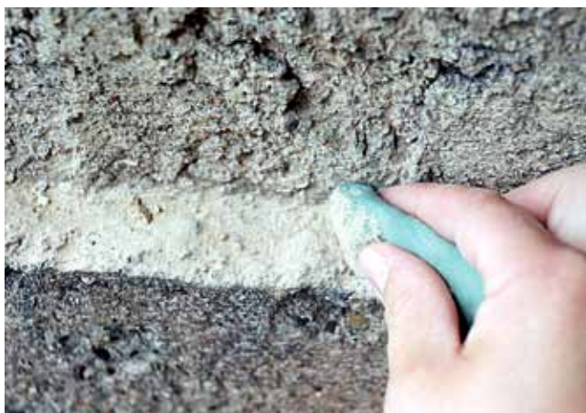
Abb. 7-18: Anwendungstechnik von Gommapane
