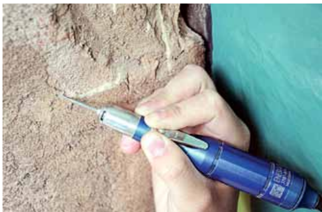
Abb. 7-19: Mechanische Entfernung von zementgebundenen Ergänzungsputzen
