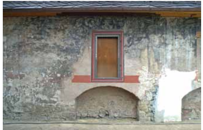
Abb. 10-8: Detail des linken Fassadenabschnitts mit der Musterachse und Rekonstruktionsversuch der Fenster- und Sockelfarbigkeit 1995, 2002
