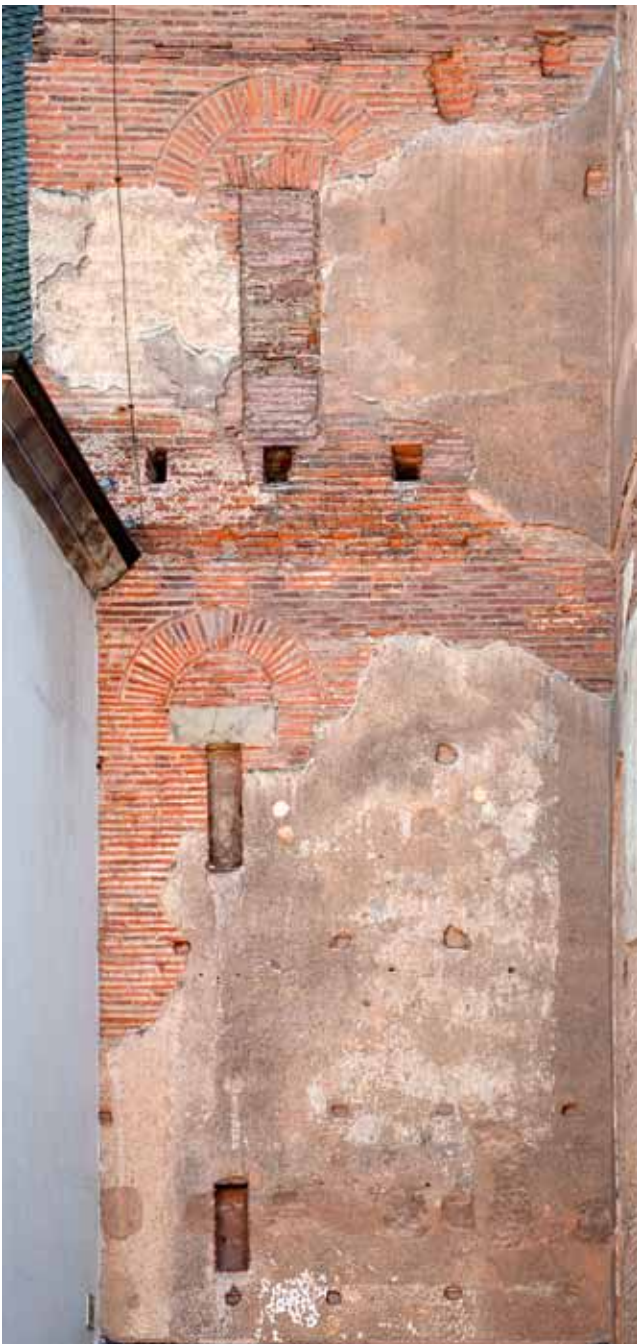
Abb. 14-16: Das Raster für die Ankerpunkte ist mit Schnüren markiert.
