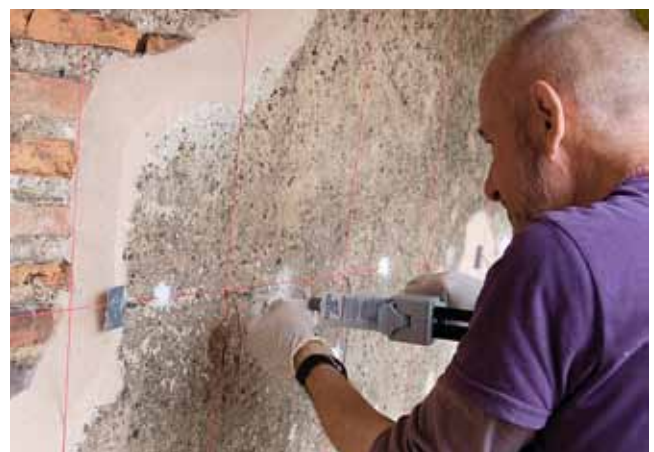
Abb. 14-17: Montage der Ankerfäden
