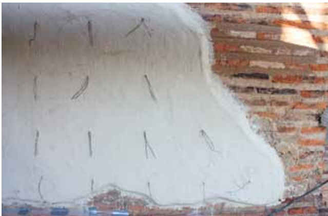
Abb. 14-22: Detailfläche nach erstem Putzauftrag
