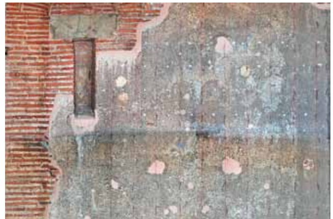
Abb. 14-16: Das Raster für die Ankerpunkte ist mit Schnüren markiert.
