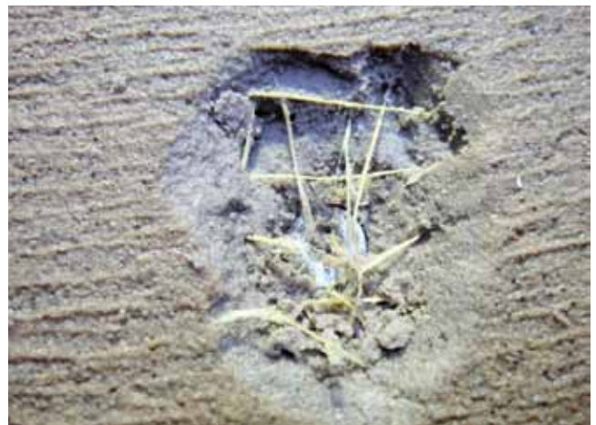
Abb. 14-11: Öffnen der Überputzung an einem Verbindungspunkt
