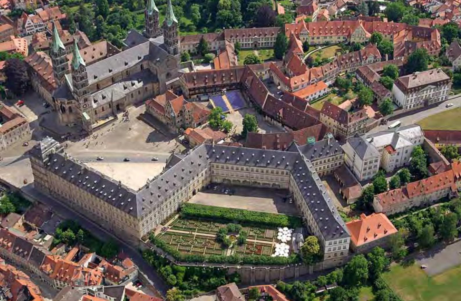
Abb. 6: Neue Residenz Bamberg, Luftbild
