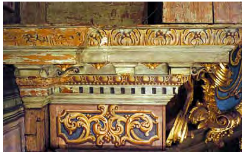
Abb. 11 Freigelegter Bereich vor und nach der „Einstimmung“ (Foto: Mathias Pfeil)
