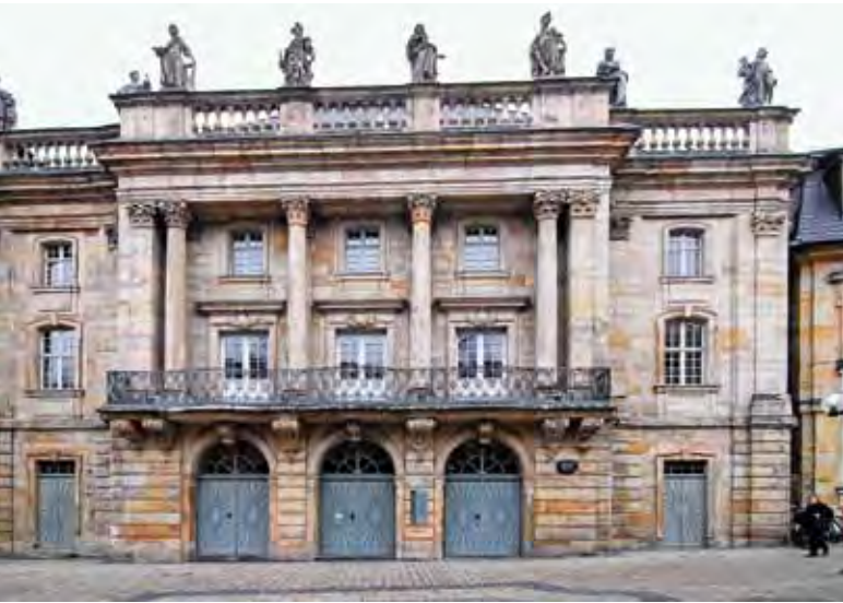
Abb. 3: Fassade des Markgräflichen Opernhauses, Architekt: Joseph Saint Pierre 1750 (Foto: Schlösserverwaltung)
