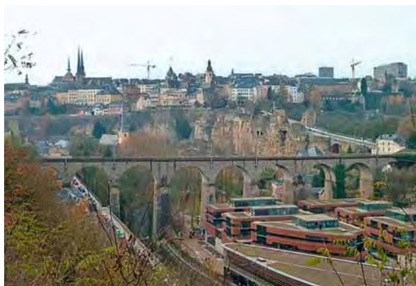
Abb. 3: Gesamtansicht der Stadt Luxemburg, im Vordergrund der Vorort Clausen
