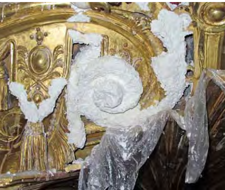
Abb. 6: Kompressenbeschichtung, um Reste oberflächennaher Magnesiumsulfate möglichst zu extrahieren bzw. zu neutralisieren (Foto: M. Staschull, 2010)
