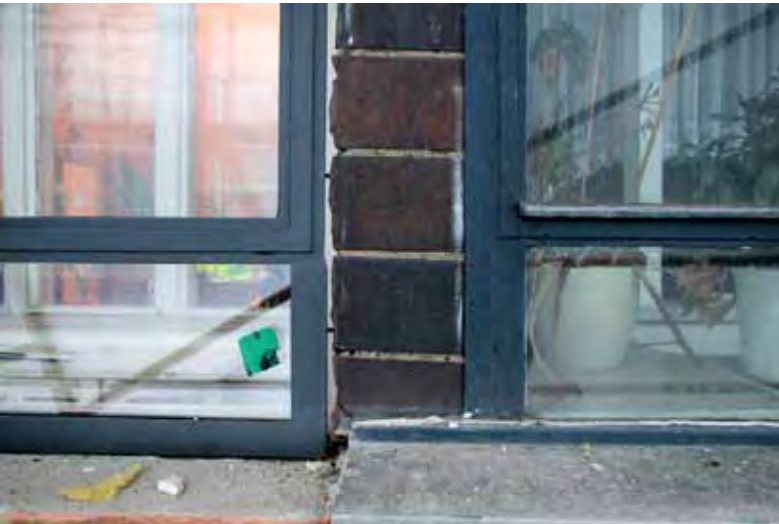
Abb. 43: Neue wärmedämmte Verandaverglasung links, ursprüngliche Verandaverglasung rechts
