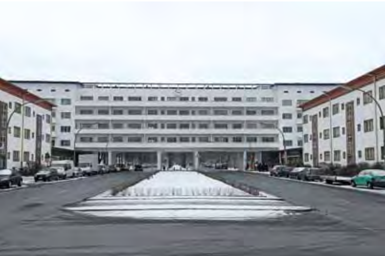
Abb. 36: Brückenhaus, im Vordergrund der von hoch wachsender Vegetation befreite Mittelstreifen der Aroser Allee
