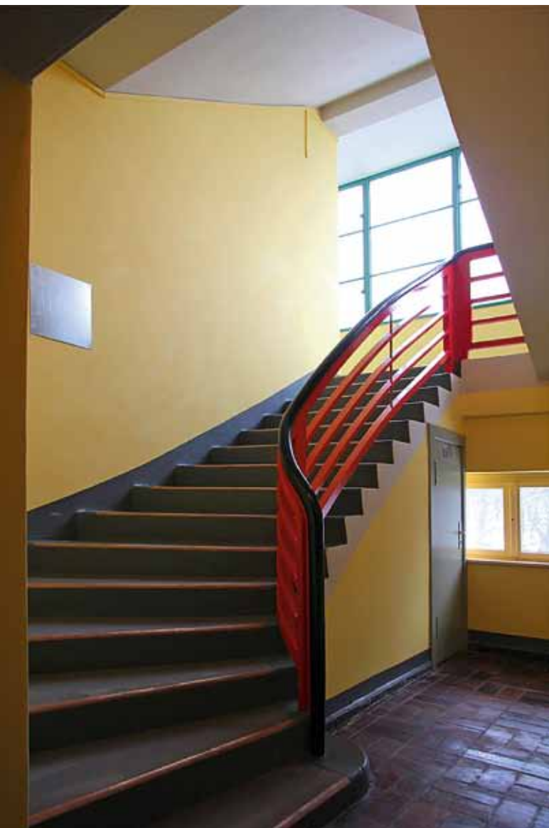
Abb. 38: Treppenhaus in rekonstruierter Farbigkeit
