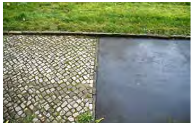
Abb. 5: Übergang vom originalen Bernburger Pflaster zu einem neuzeitlichen Asphaltbelag
