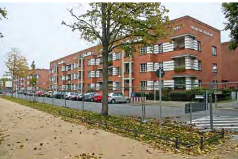
Abb. 8: Siedlung Schillerpark von der Parkseite
