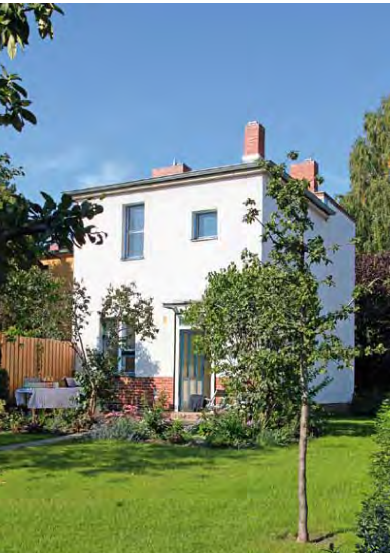
Abb. 26: Das in privater Initiative entstandene Gästehaus „Tautes Heim“ an der Gielower Straße 43
