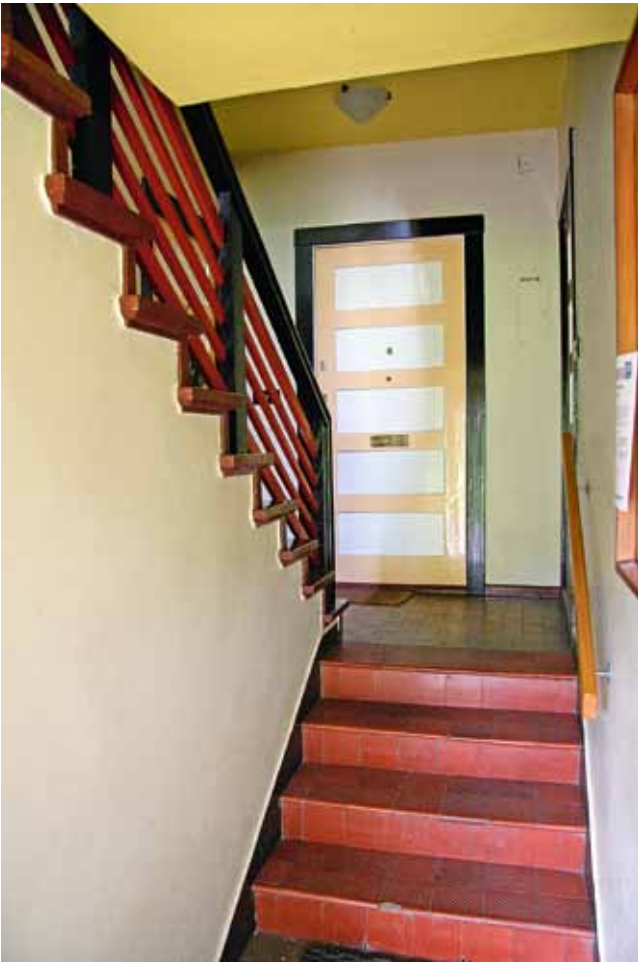
Abb. 9: Das Treppenhaus nach der Instandsetzung
