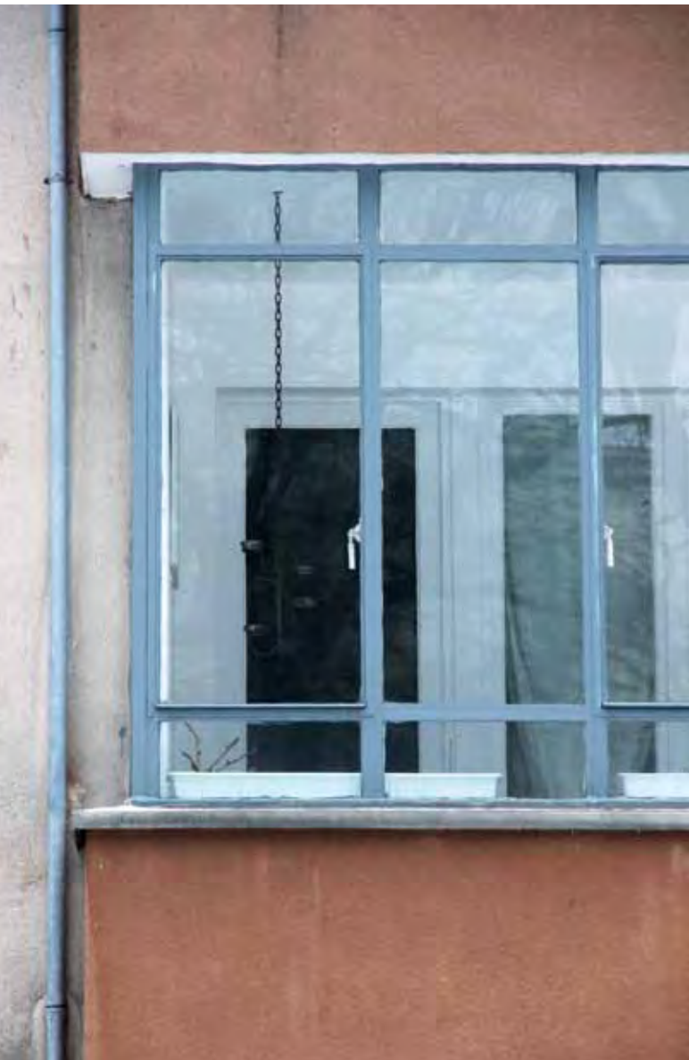
Abb. 42: Ursprüngliche unbeheizte Verglasung der Veranden
