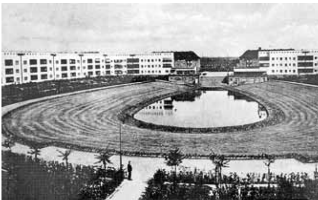
Abb. 16: Das Hufeisen kurz nach seiner Fertigstellung
