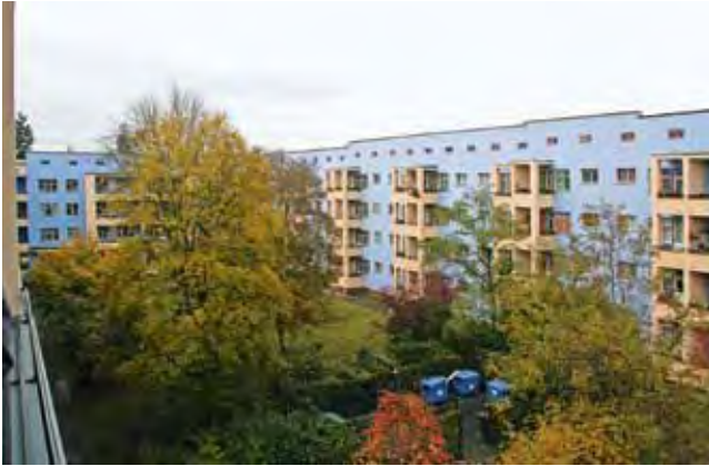
Abb. 30: Fassaden zum Hof mit differenzierter Farbgebung
