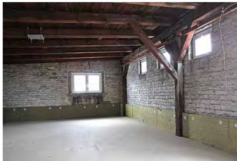
Abb. 29: Wärmedämmung der obersten Geschossdecke, gut erkennbar das Hochziehen der Dämmung zur Vermeidung von Wärmebrücken
