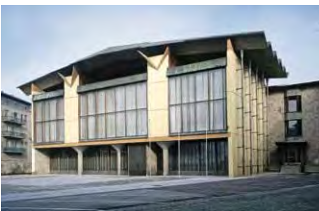
Fig. 7: The Town Hall Building in Kranj introduced contextual regionalism, which intensively developed in the 1960s and 1970s. Architect: Edvard Ravnikar, 1958–60 Abb. 7: Das Rathausgebäude in Kranj/Krainburg führte den kontextuellen Regionalismus ein, der sich intensiv in den 1960er und 70er Jahren entwickelte, Architekt: Edvard Ravnikar, 1958–60
