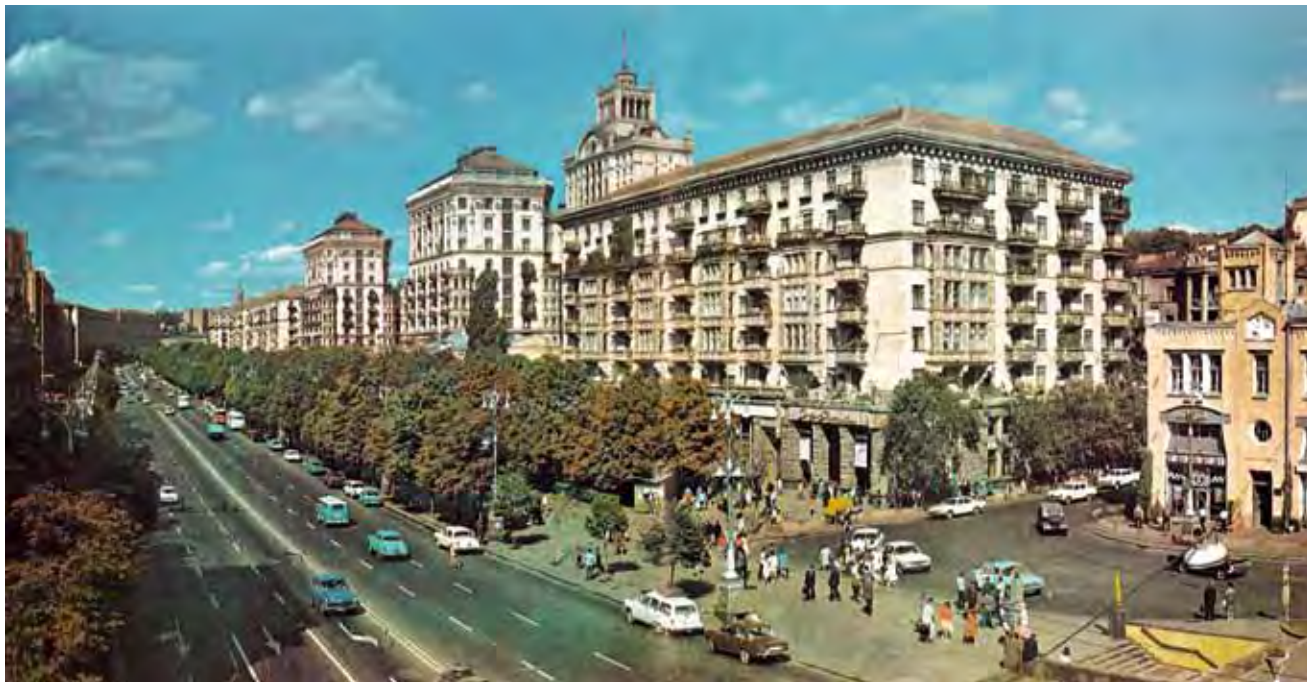
Fig. 3a: Kyiv. Khreschatyk. The side of the residential area. Photo: Мезенцева Г., Мезенцев И. Киев. Фотоальбом. – Киев, „Будівельник“, 1981
