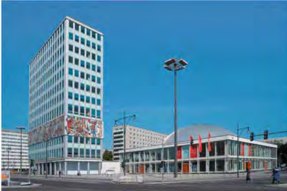
Karl-Marx-Allee, II. Bauabschnitt (Landesdenkmalamt Berlin, Foto: Wolfgang Bittner 2010). Haus des Lehrers am Alexanderplatz (1959-1964, Architekt: Hermann Henselmann).
