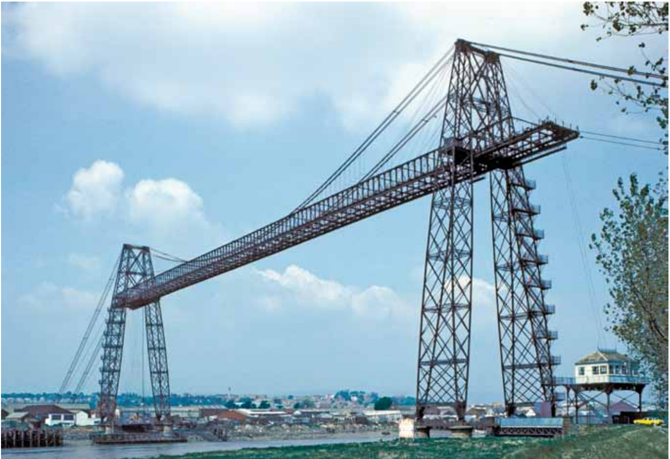
Abb. 2: Transporter Bridge in Newport/Wales, 181 m Spannweite, 1906 von Ferdinand Arnodin, 2010
