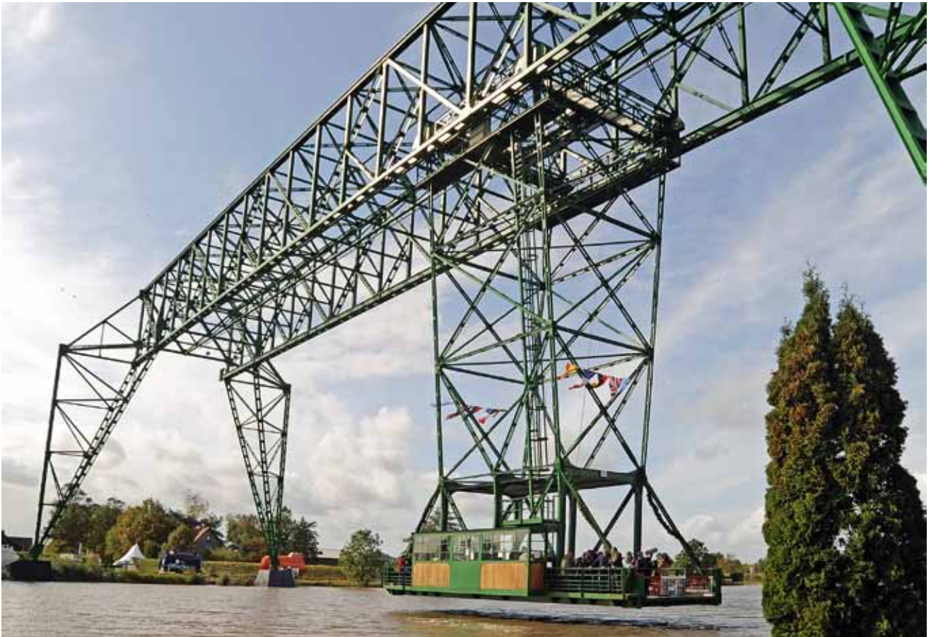
Abb. 3: Die hundertjährige Schwebefähre über die Oste im niedersächsischen Osten/Hemmoor linksseitig der Elbe
