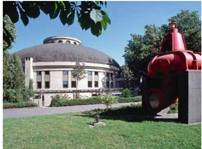
Abb. 2: Pumpwerk Duisburg „Alte Emscher“, 2010
