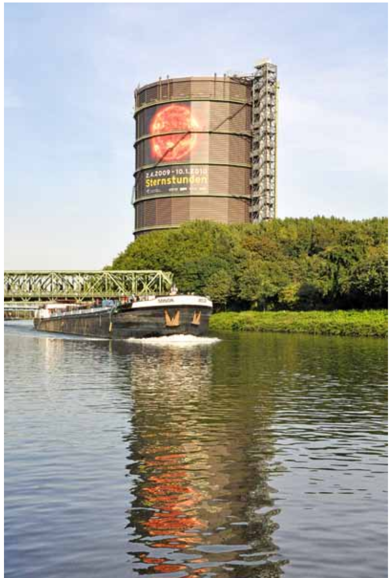
Abb. 5: Scheibengasbehälter der Gutehoffnungshütte Oberhausen, heute Veranstaltungsort „Gasometer Oberhausen“
