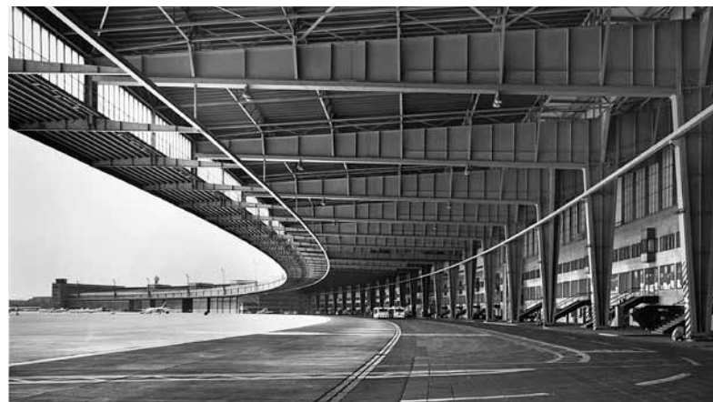
Abb. 4: Flughafen Tempelhof, Ingenieurtechnik am Flugfeld, 1994
