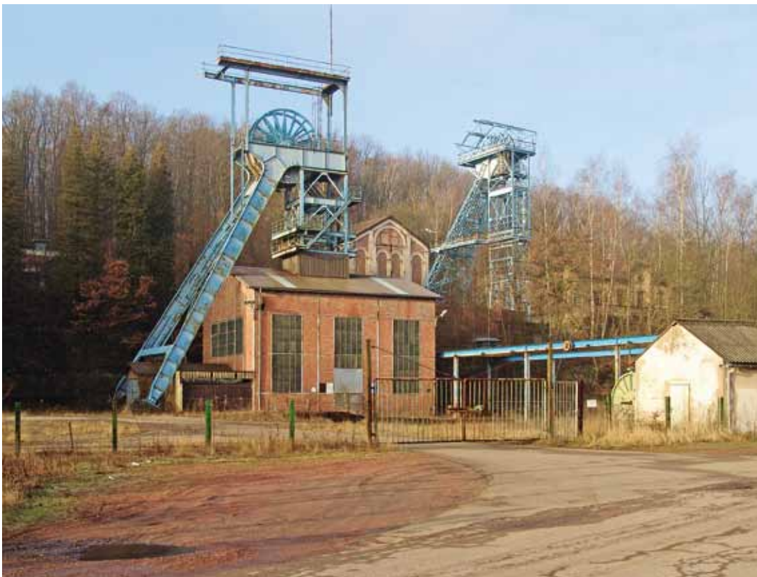
Abb. 1: Ältestes Fördergerüst des Saarlandes auf der Grube Itzenplitz 1886, 2005
