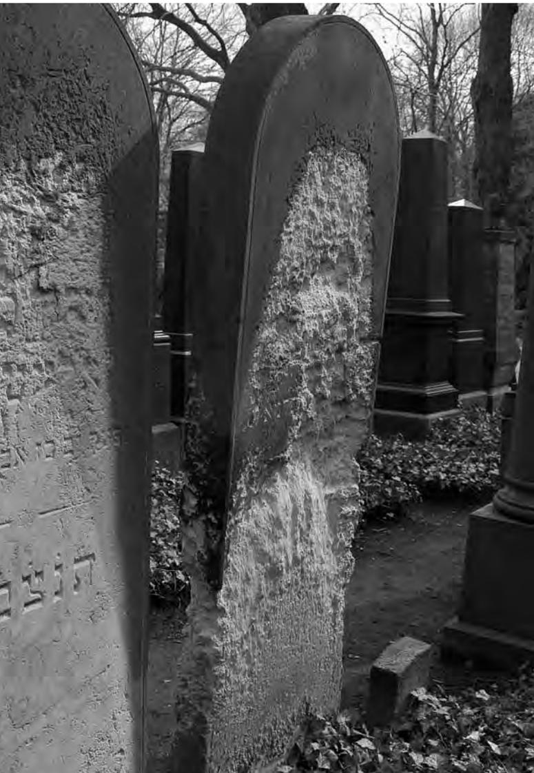
Abb. 6 Sandsteintafel ohne Unterbau mit Rundbogen als oberem Abschluss. Der sächsische Sandstein ist hier durch Verwitterung soweit ausgedünnt, dass er zu brechen droht. (Foto: TU Berlin 2008)
