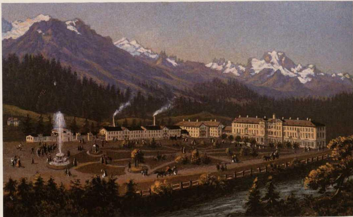
10: St. Moritz-Bad, die Kurhäuser, um 1870
