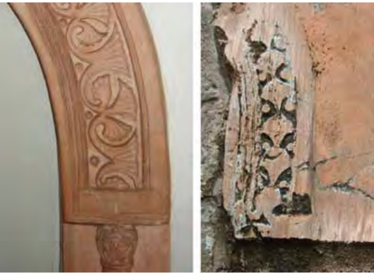
Abb. 3: Arnstadt, Kirche Oberndorf, romanischer Gipsstuck im Innenraum (links) und auf der Außenfassade (rechts)
