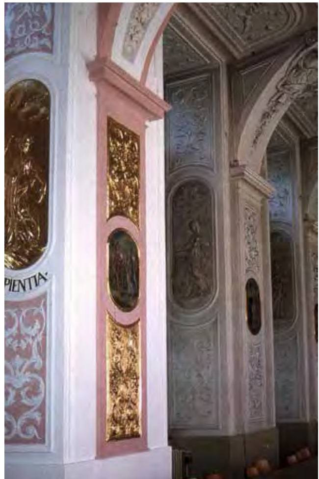
Abb. 11: Lambach, OÖ, Stift, Sommerrefektorium von Diego Francesco Carlone 1709, Musterachse der zur späteren Freskoausstattung 1740 erneuerten Stuckfassung (Mag. Herbert Schwaha 2005)
