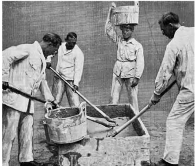
Abb. 3: Anrühren von Gips- oder Kalkmörtel
